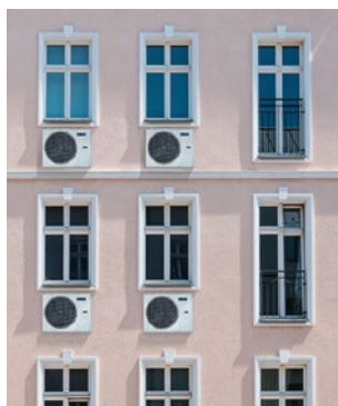
Herkömmliche Lösung mit Außeneinheit
