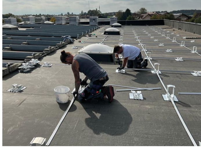
Die Bauarbeiten von Nikolaus Bogensberger (im Vordergrund) und Raphael Mühlbacher, beide Firma E-Technik Pablinger GmbH.
