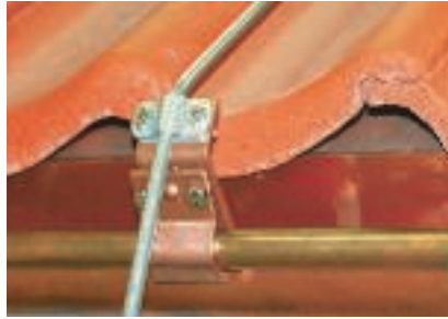
Korrekte Installation mit Zweimetall-Verbinder (Alu/Kupfer)
