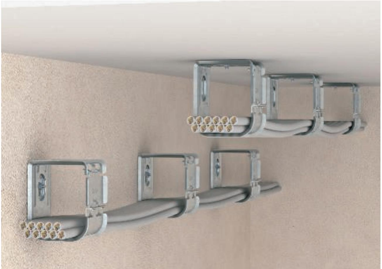
Sammelhalterungen eignen sich zur Installation oberhalb von Zwischendecken oder abgehängten Brandschutzdecken in Flucht- und Rettungswegen. Dafür wurde die mechanische Tragfähigkeit im
