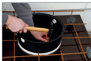
Bei Ort beton auf Schalung nageln, im Fertigteilwerk auf Schaltisch kleben.
