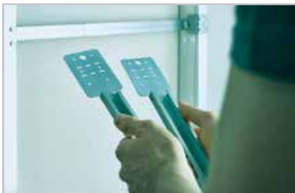
1. Montageschiene wird als vormontiertes Paar angeliefert.
