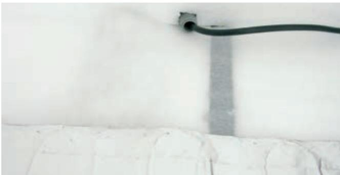
**WICHTIG:** Achten Sie darauf, dass das eingestemmte Fühlerschutzrohr zwischen den Heizleitern zum Liegen kommt. Danach werden der Temperaturfühler und das Anschlusskabel in die Rohre eingezogen.
