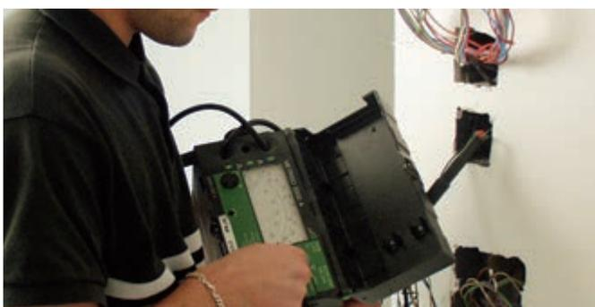
Jeweils nach der Auslegung und nach der Fertigstellung des Bodenbelages ist Laminotherm auf Durchgang, Widerstand und Isolationswert zu prüfen, mit dem Widerstandswert auf dem Leistungsschild zu vergleichen und in das Prüfprotokoll einzutragen.
