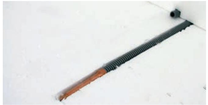
Einstimmen der Fühlerleitung, ggf. Bereich aus Trittschalldämmung ausschneiden und das Fühlerschutzrohr anmuffen. Achten Sie darauf, dass der Fühler später nicht mit Möbeln überdeckt werden kann. Am besten vor einer Tür platzieren.
