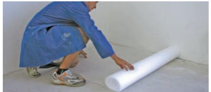
Auslegen der Trittschalldämmung. Als Unterboden kann prinzipiell jeder Unterbelag verwendet werden.
