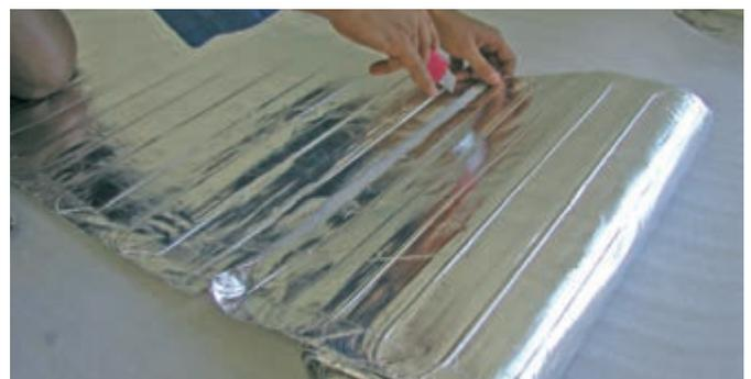
Durch Einschneiden des Aluminiumgewebes, wird die Lamiotherm dem Grundriss entsprechend angepasst.
