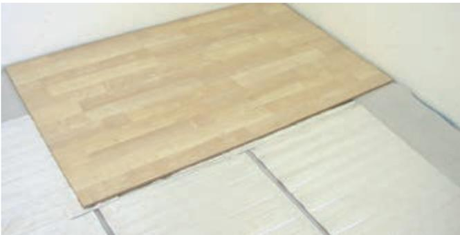
Nach der kompletten Verlegung der Laminotherm-Heizmatte und der Kaltenden zwischen Laminat und Wand kann der Boden schwimmend verlegt werden.
