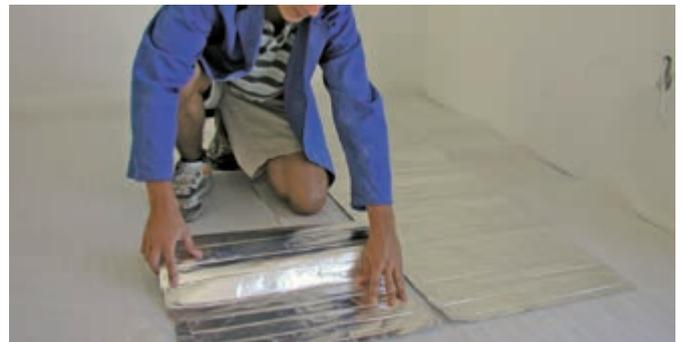
Beginnend bei der Anschlussdose, wird die Matte gemäß Verlegeplan ausgerollt und angepresst.
