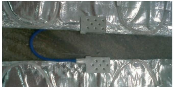
Wenn die Matten umgelegt werden, müssen die einzelnen Teilflächen über mitgelieferte Pressverbinder verbunden werden, damit eine vollständige Erdung des Heizelements gewährleistet wird.
