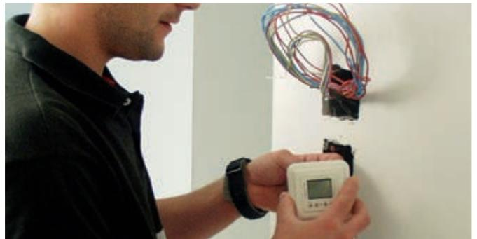
**ACHTUNG:** Der Anschluss darf nur von einem konzessionierten Elektrounternehmen durchgeführt werden. Die nationalen und internationalen Anschlussvorschriften sind einzuhalten. Laminotherm ist für den festen Anschluß in einer UP-Installationsdose vorgesehen.
