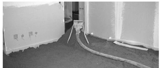
Ist ein **Baustahlgitter** vorzusehen, z. B. bei großen Flächen mit erhöhter Belastung, muß dies **über die Heizmatte** gelegt werden, um Quetschungen bei den weiteren Arbeiten zu vermeiden. Für die weitere Estrichaufbringung ist ein Brett aufzulegen, wenn der Estrich mit dem Schubkarren transportiert wird. Bei Pumpbeton ist darauf zu achten, daß der Fuß des 3-Fußes die Heizleitung nicht beschädigt bzw. 3 kleine Bretter unter die Füße gelegt werden.
