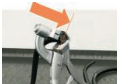
5. Kabel längs auf gegenüberliegenden Seiten einschneiden
