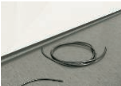
1. Leitung auf gewünschtes Maß abgelängen und von Schmutz befreien
