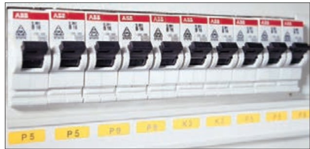
Kennzeichnung im Schaltschrank.
