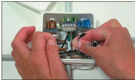
Lösen des Leiters durch Drehen und Ziehen
